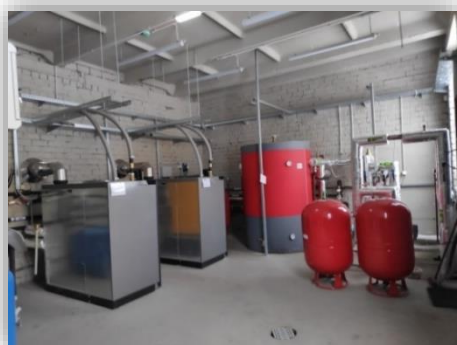
7 pav. Lavoriškių katilinė po rekonstrukcijos
